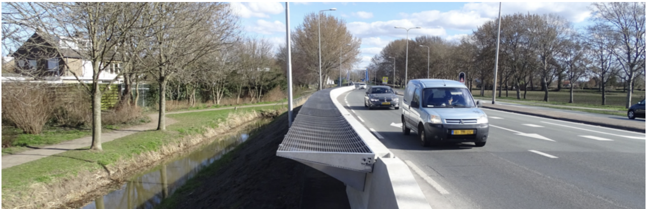
Combinatie van een betonnen barrière en metalen diffractor. Beeld: 4Silence
